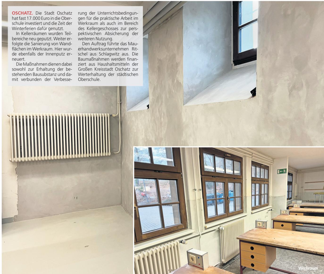
Die Bauarbeiten in der Oberschule sind abgeschlossen: In den Nebenräumen im Keller wurde der Putz erneuert, zudem der Werkraum hergerichtet.
